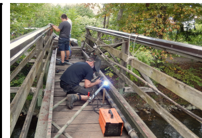
Sanierung Amper-Brücke am G.-A.-Hs.
